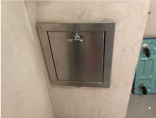
Trash chute door
